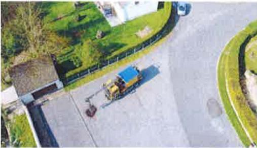
Cet outil polyvalent capable de réaliser des pièces d'enrobé de qualité, plus résistantes dans le temps qu'un enrobé à froid, nous a permis de prendre en considération toutes les voies communales :
